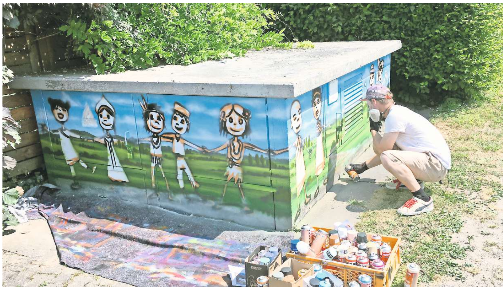
Tanzende Kinder aus unterschiedlichen Kulturkreisen: Ole Görgens verziert einen Trafokasten in Jeinsen.
